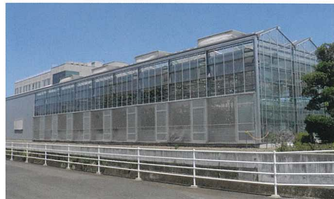
左 / 井関農機株式会社様と愛媛大学との共同研究により誕生した太陽光利用型植物工場。
