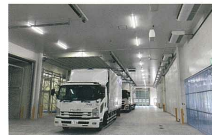
冷蔵庫内のトラックヤード
